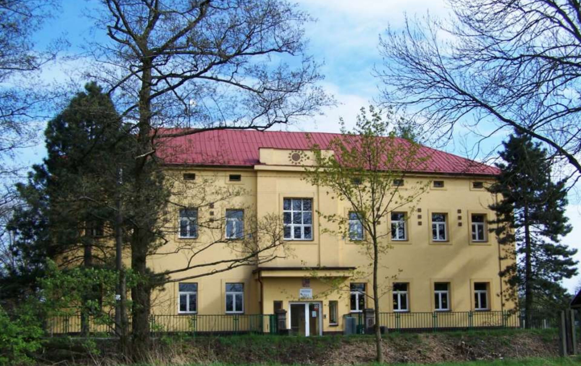
Školka v budově bývalé školy v Koukolné z r. 1908
