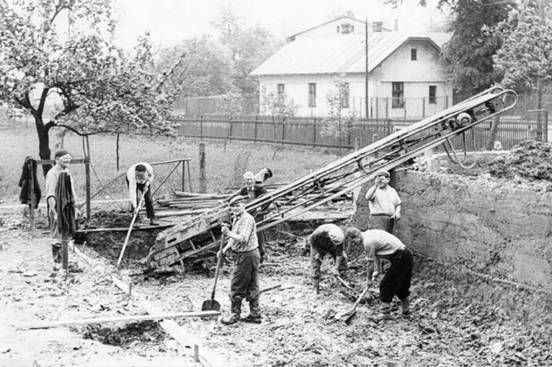
Výkopové práce při stavbě domu č.p. 942 tzv. Jitřenky (dnes knihovna) vedle fary v akci „Z“. V horní části snímku je vidět domek č.p. 207, který byl později zbourán při výstavbě nové silnice. Akce „Z“ byla dobrovolná výstavba občanů zdarma pro svou obec. Většinu staveb později nabyli za symbolickou cenu soukromníci.
